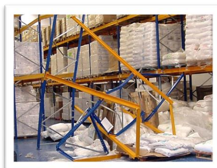
Estructura colapsada por un golpe severo
